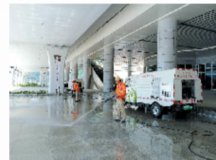
环卫工人用纯电动路面养护车养护路面
