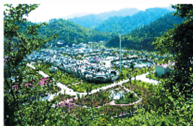
神定河污水处理
