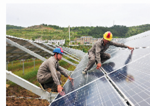
国网十堰供电公司在郧阳区铺设光伏发电太阳能板
