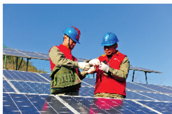
积极服务光伏扶贫项目
