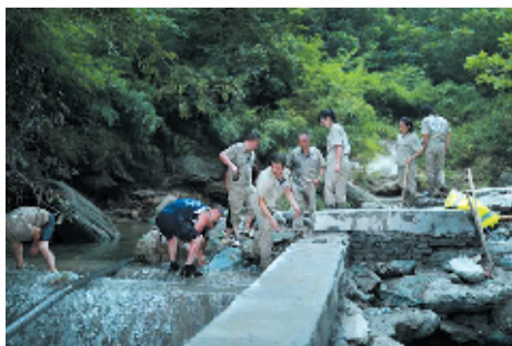
铺设自来水管线
