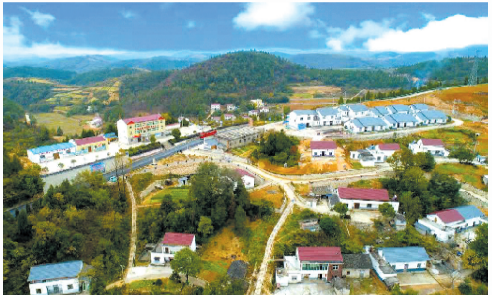
郧阳区域城关镇新农村建设
