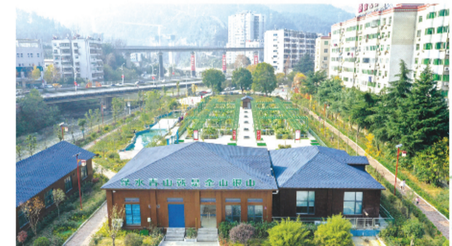
车站沟花园式污水处理微站
