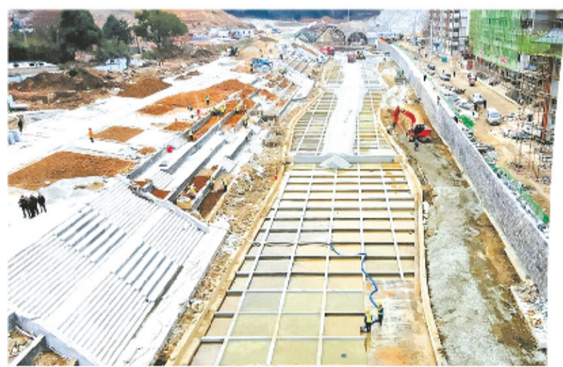
百二河生态修复工程一标段紧张施工中 记者金正 摄
