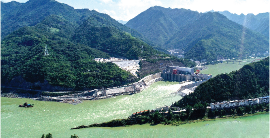
汉江入鄂第一水电站——夹河关电站
