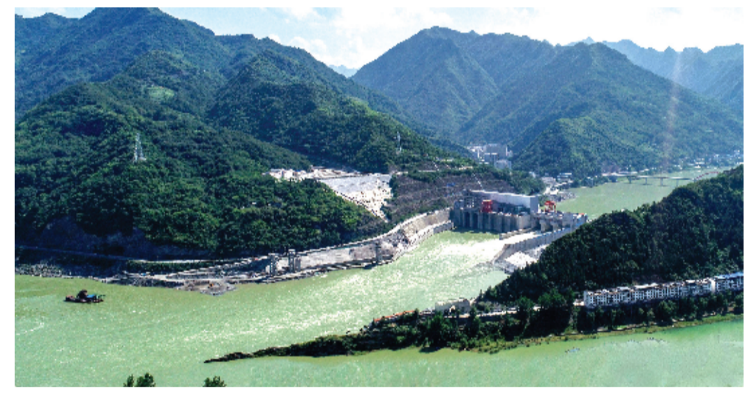
汉江入鄂第一水电站——夹河关电站
