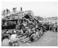
建厂初期建设厂房
