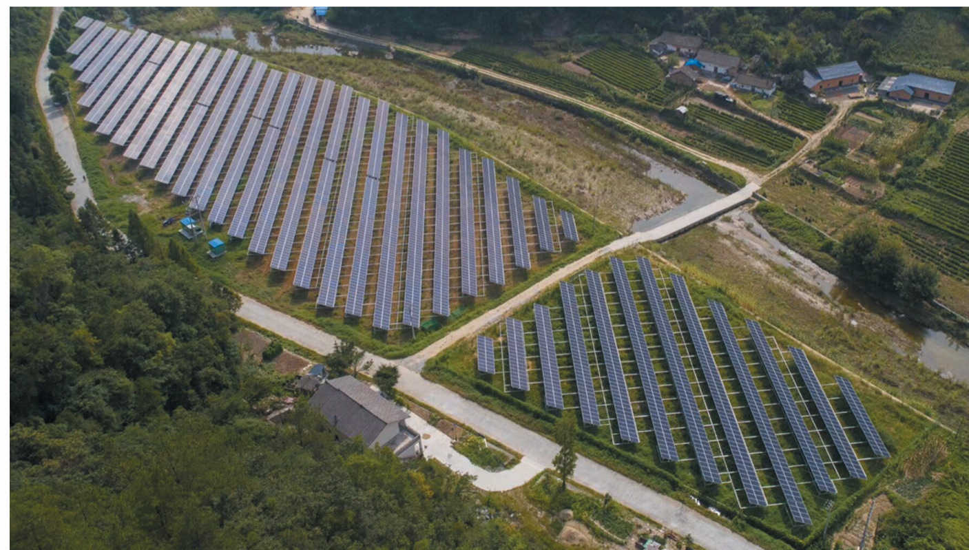
茅塔乡大坪村光伏电站
