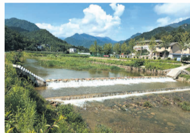
泗河流域系统治理工程(茅箭段)茅塔乡廖家村漫水桥
