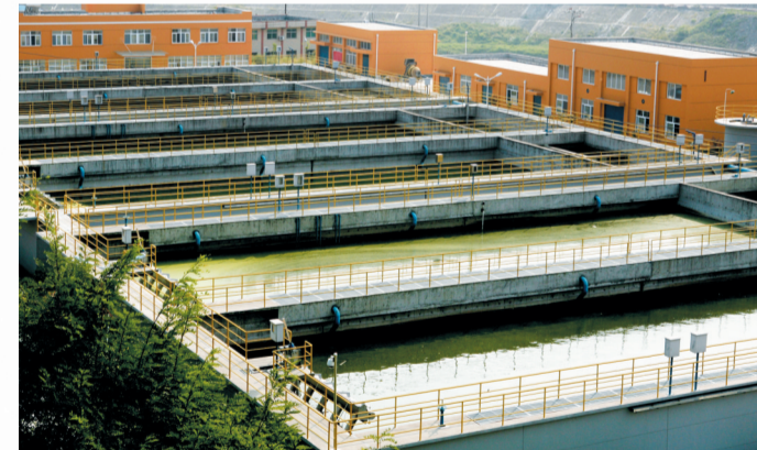
水 污水处理设施
