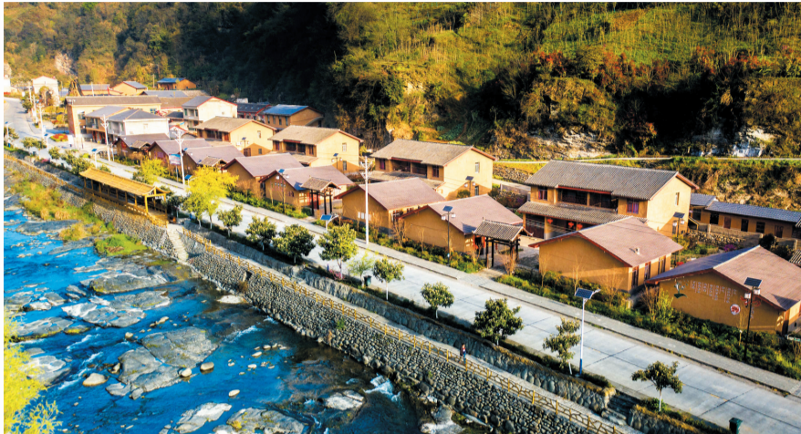
泉溪镇石板河矿院安居工程
