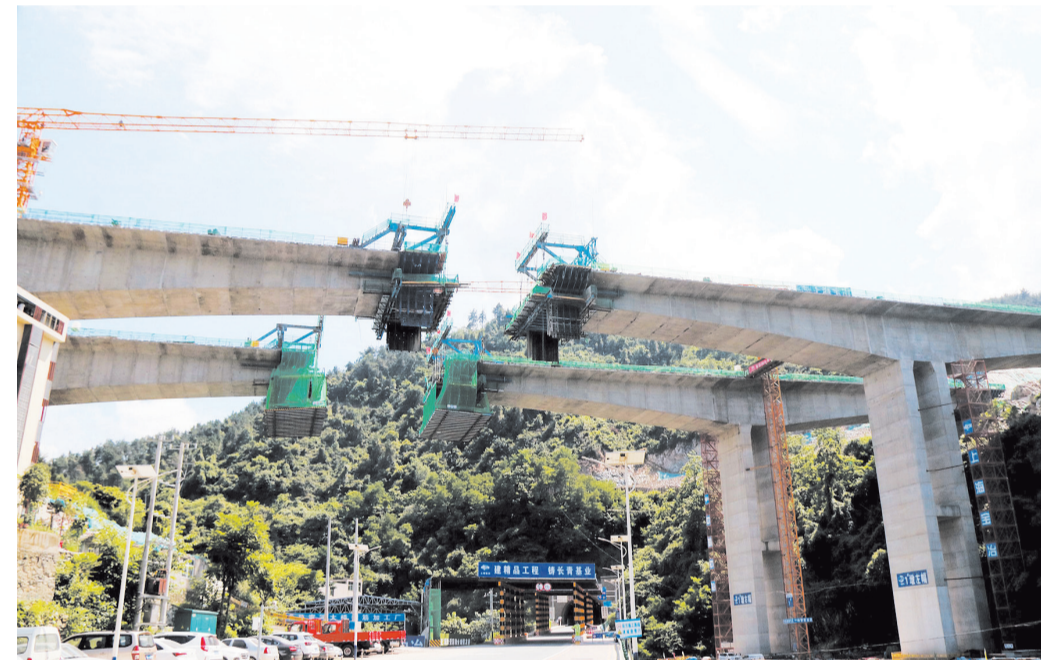
7月8日，武当路复线马家河大桥施工现场，工人们抢抓晴好天气加紧施工。马家河大桥是武当路复线重点控制性工程，桥梁总长250米。据了解，武当路复线全长9.57公里，工程建成后，对于打通城区外环、提升城市交通服务功能、拓展城市发展空间具有重要意义。 通讯员薛永生 摄
