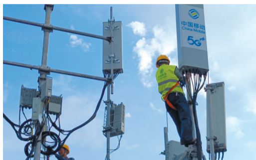
十堰移动5G基站建设
