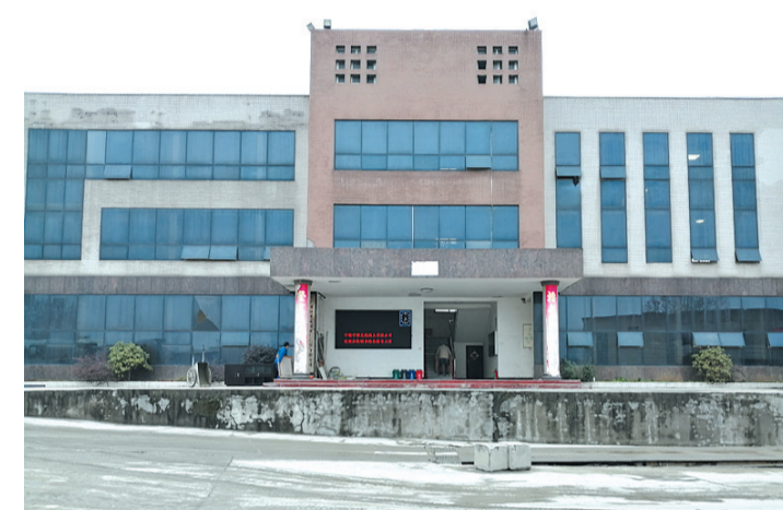
十堰郧发混凝土工程有限公司办公楼
