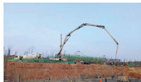
为项目建设运送商品混凝土
