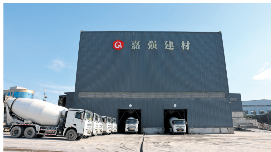
公司厂房一角
