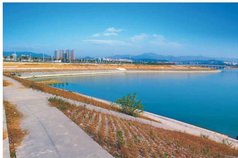
郧阳区库岸治理综合项目
