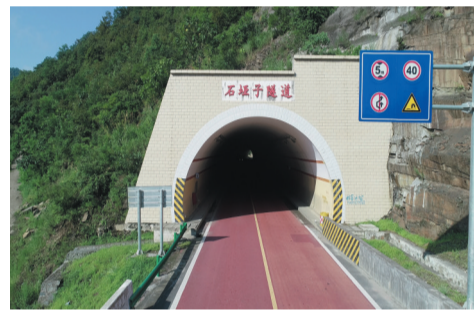
承建的十竹路改扩建项目石堰子隧道
