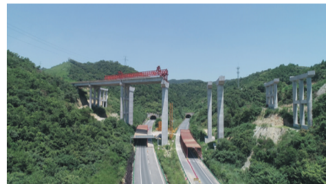
承建的十堰高铁东站至武当山机场一级路跨呼北高速大桥
