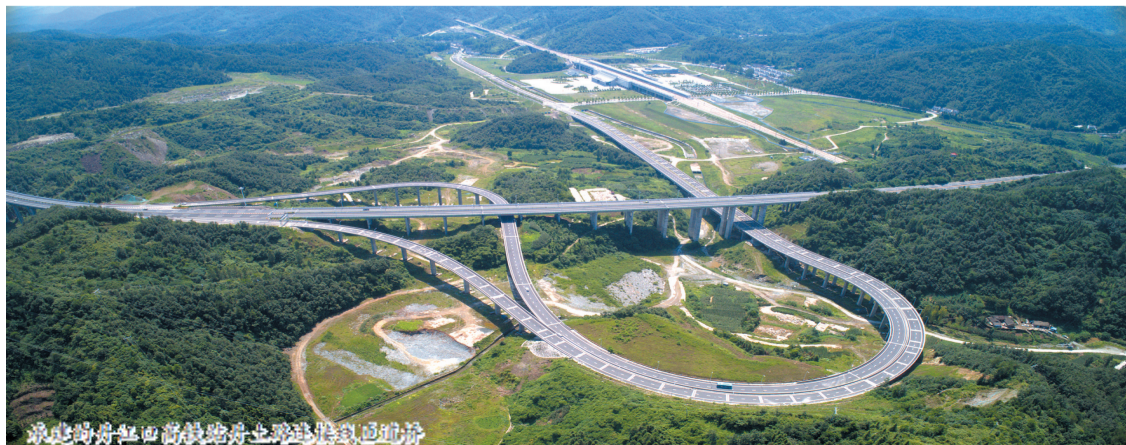
承建的丹江口高铁站丹土路连接线匝道桥
