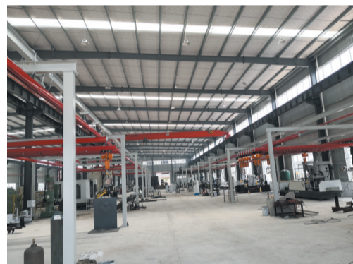
桥壳吊装KBK线
