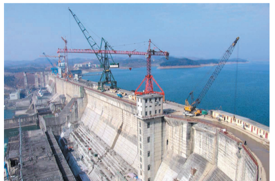
丹江口水利枢纽大坝加高工程
