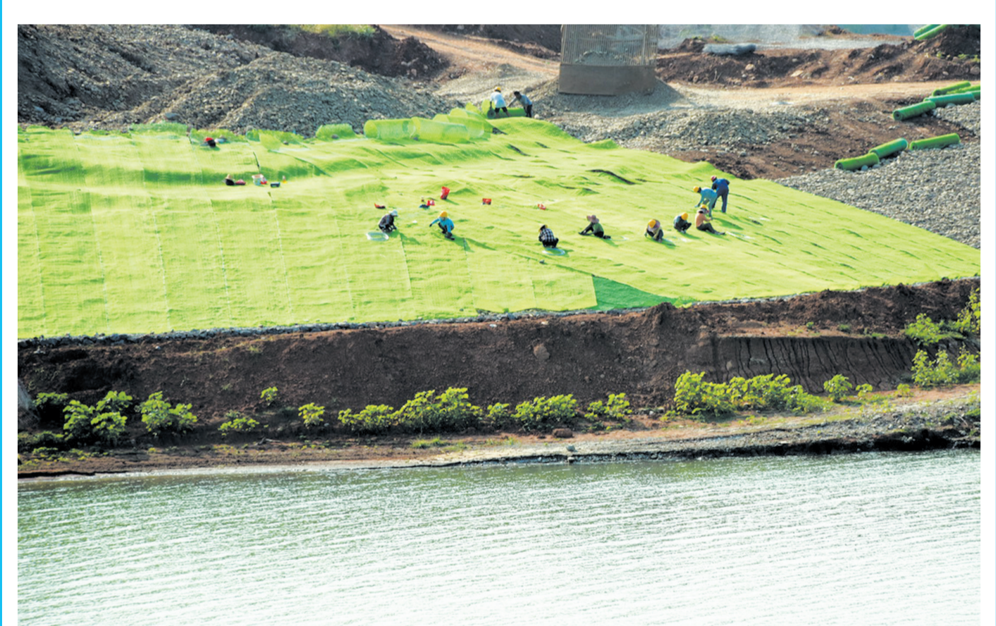
近日,鄠阳区汉江北岸杨溪铺堤岸工程正加紧建设。丹江口库区库岸带综合治理鄠阳区段一期工程总投资29939.41万元,总工期36个月,防洪标准为20年一遇。主要建设内容为库区汉江干流整治护岸17.446公里,其中该区柳坡镇段5.19公里,城关镇马场关段3.832公里,杨溪铺香菇小镇段8.424公里;支流棒槌河整治护岸1.139公里,疏浚河道0.368公里。目前,丹江口水库库岸带综合治理工程已完成30%,完成投资7000万元。
