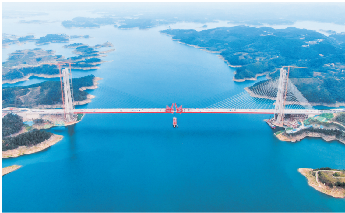
横跨辽阔水面的丹江口水库特大桥。记者朱江 张萌 邵汶彬摄
