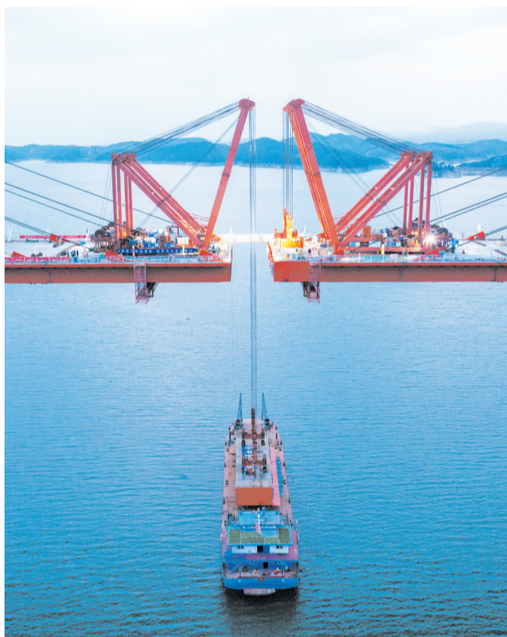
大桥跨中无轴连接装置吊装现场。记者刘昆 摄
