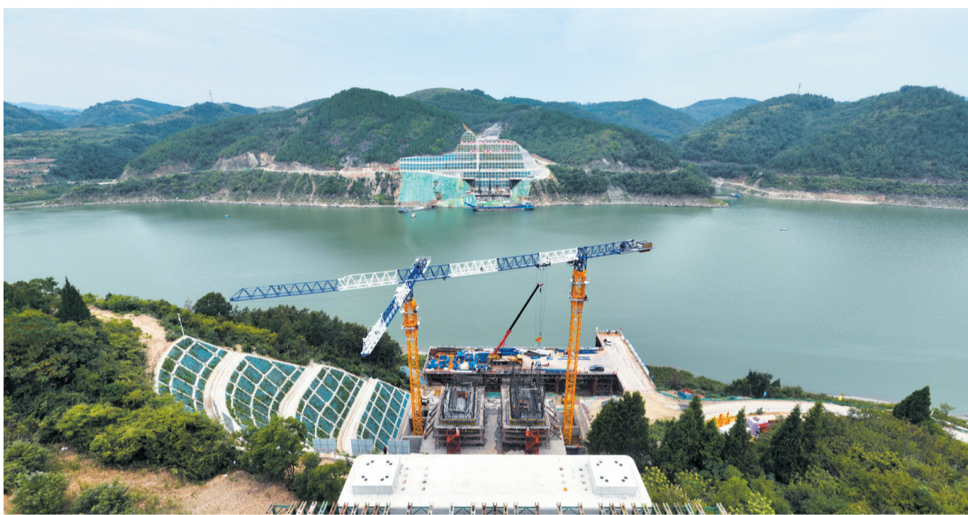
西十高铁汉江特大桥建设现场。 记者刘旻 摄
