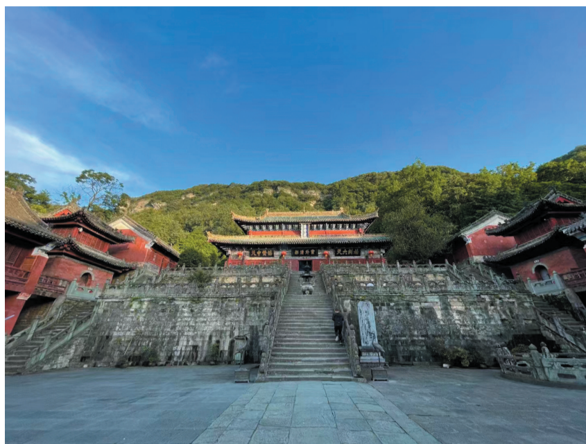
武当山紫霄宫东西宫维修工程
