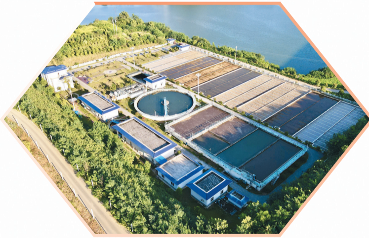
郧阳污水处理系统
