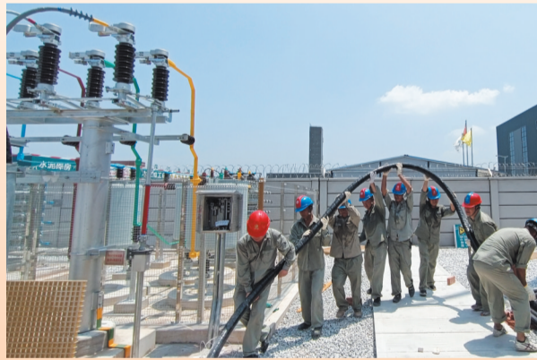
高压电缆展放
