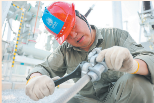
施工人员进行导线金具组架
