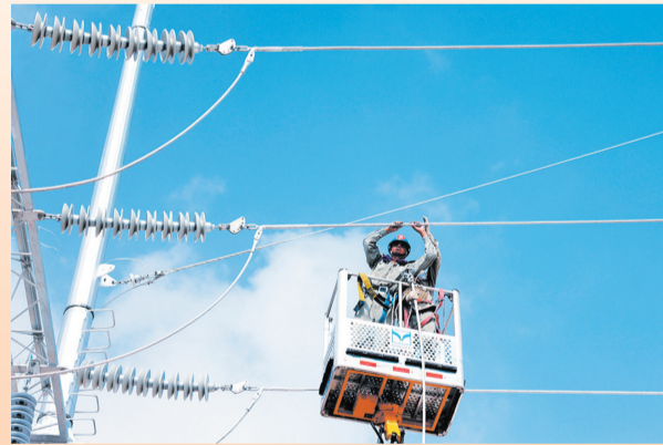
线路引线安装
