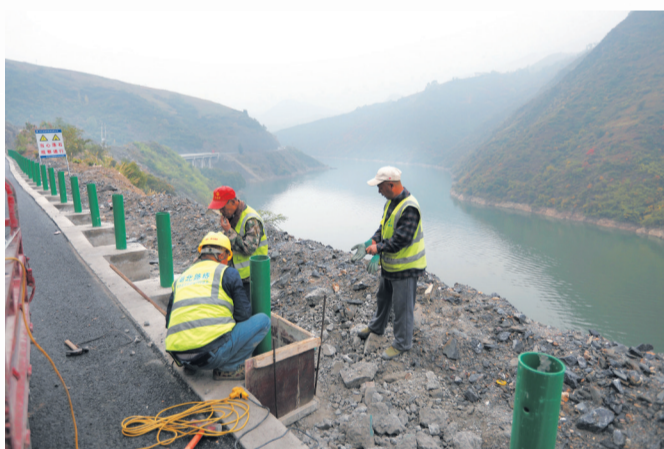
施工人员为金钱河左岸的上(津)六(郎)公路安装防护栏。(2022年10月25日摄)
