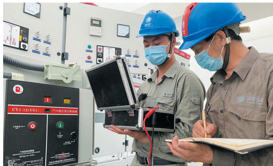
修试计量班 调试10千伏高压配电柜
