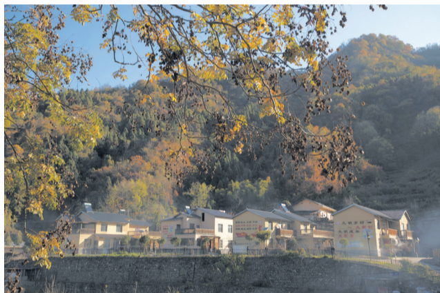
位于泗河上游的茅箭区赛武当自然保护区管理局小村刘家院易迁安置区。(2022年11月14日摄)
