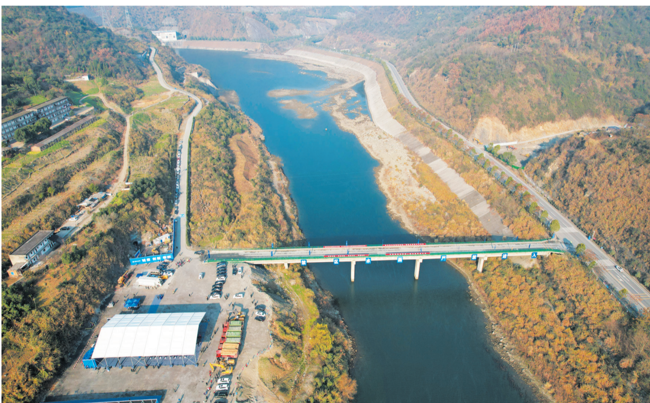
潘口抽水蓄能电站暨2022年12月全市重大项目集中开工活动现场。
