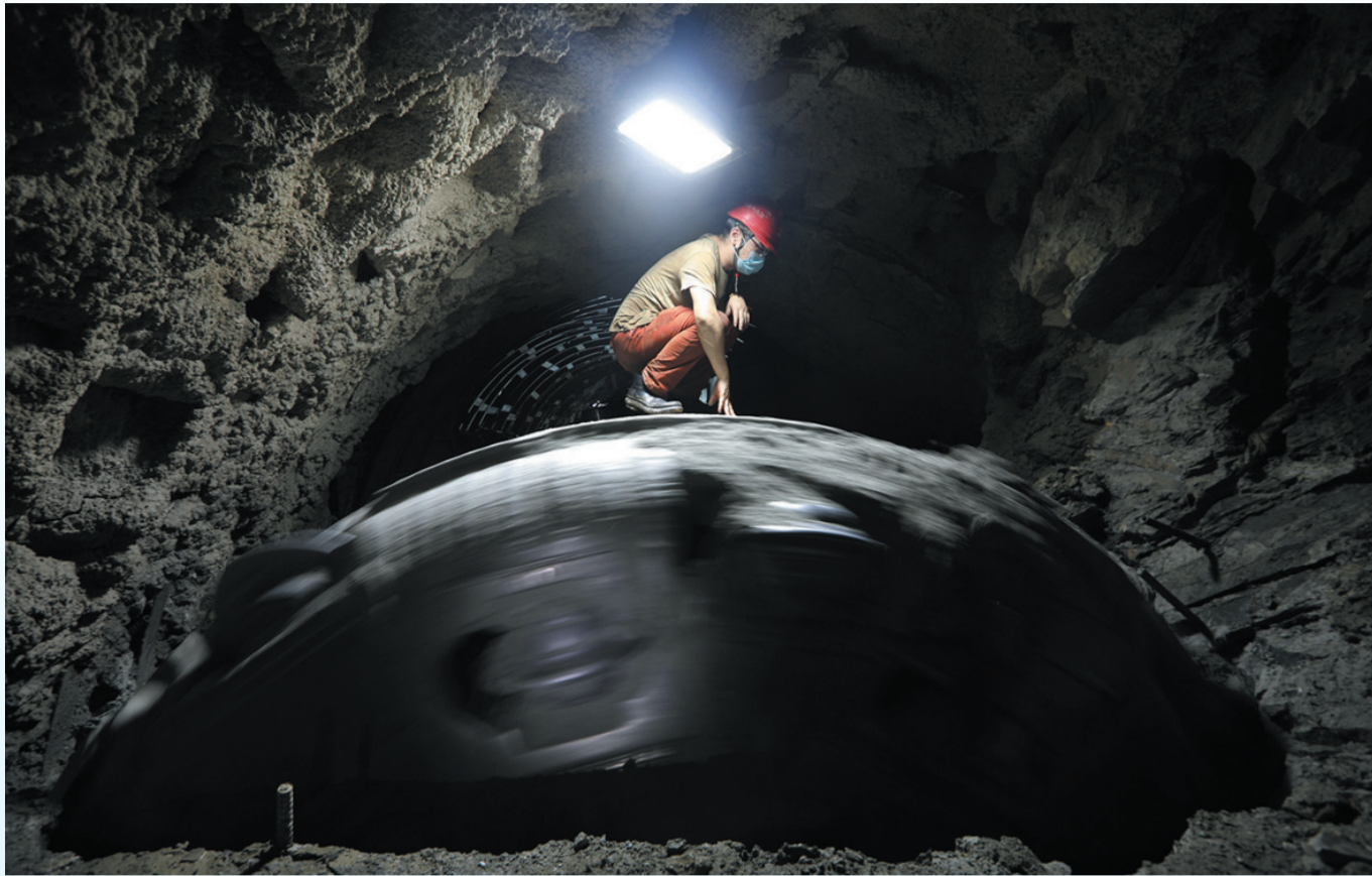
十堰市中心城区水资源配置工程四标段技术人员在作业面观察旋转维护的TBM全断面硬岩掘进机。
