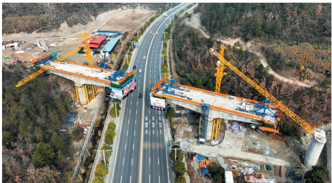
十西高铁项目(十堰段)加紧建设
