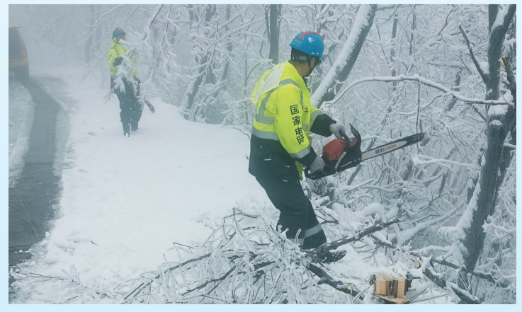
冒雪开展电力抢修。
