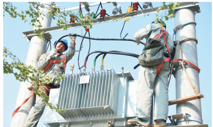
在高温下为疫情防控集中医学观察点架设变压器。
