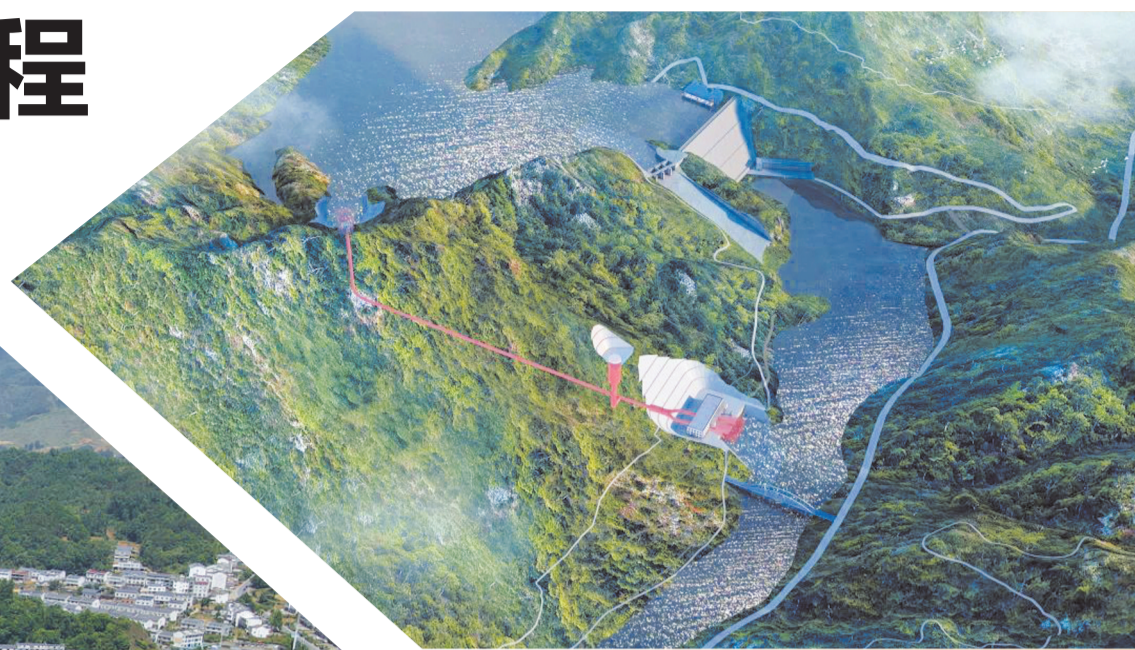
湖北潘口抽水蓄能电站项目稳步推进
