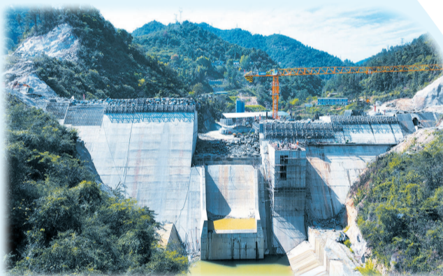
茅箭区朱家咀水库施工现场 记者刘昱 摄
