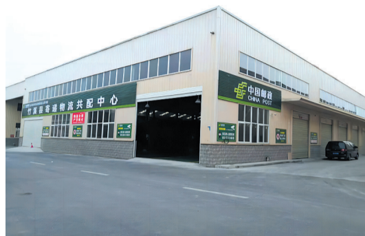
竹溪县邮政共配中心改造升级
