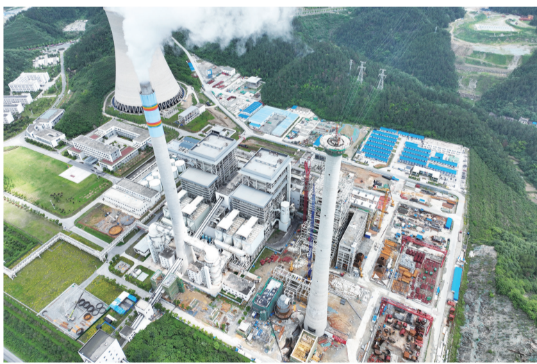
京能十堰热电二期项目建设现场
