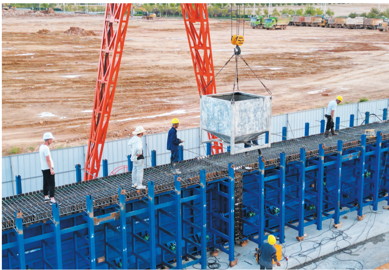
神定河大桥建设现场
