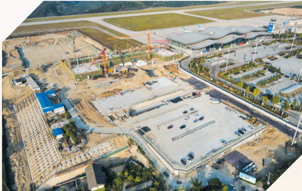
十堰武当山机场国际航站楼建设
