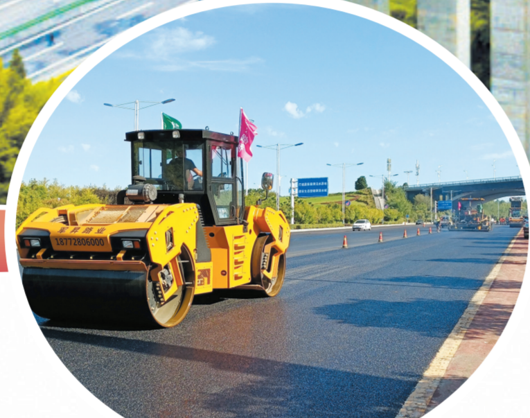
十堰大道大中修施工路面压实作业
