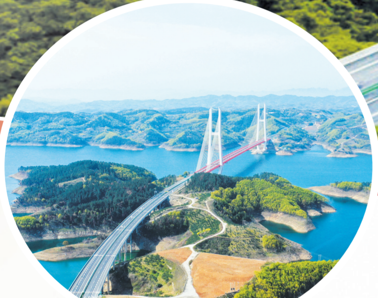
十堰高速湖北段丹江口特大桥
