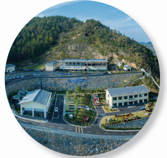
建成后的竹溪县新胜水厂
