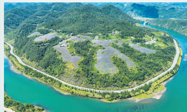
潘口乡龙王沟村光伏电站 通讯员王俊 摄
