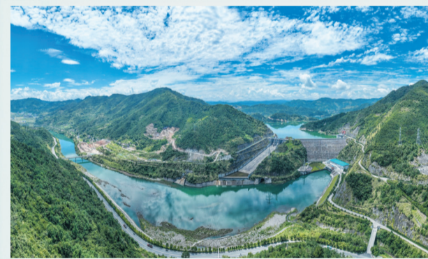
建设中的潘口抽水蓄能电站 通讯员王俊 摄
