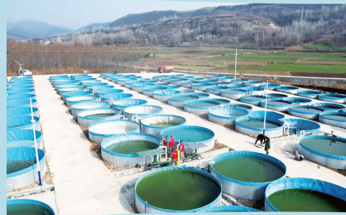
为水产养殖提供电力保障。
