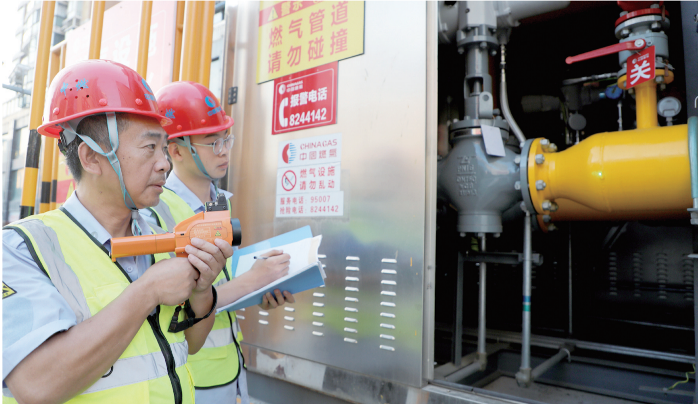
工作人员使用激光甲烷检测仪检测是否有天然气泄露。
