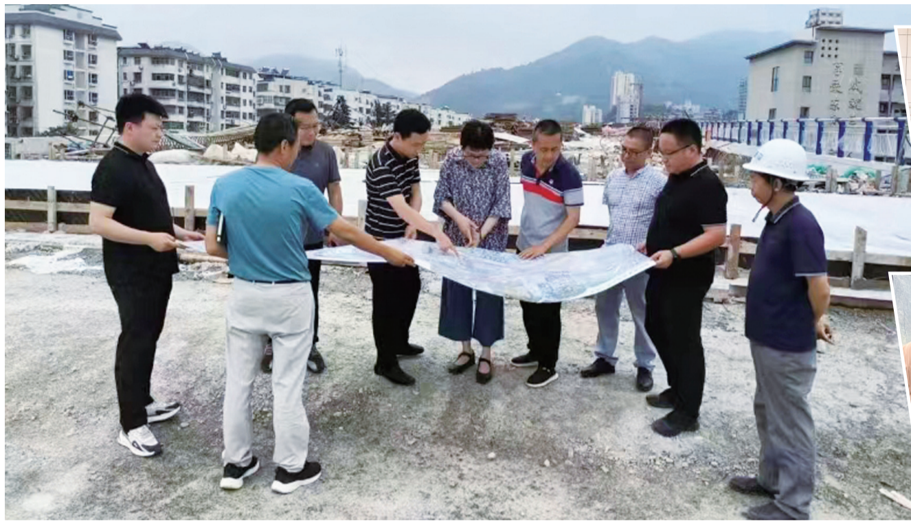
审计人员在朝阳南路项目建设现场踏勘
