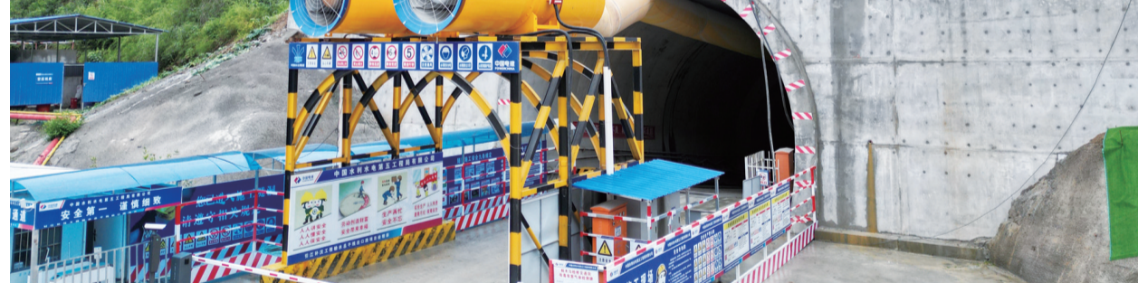
检修交通洞贯通
