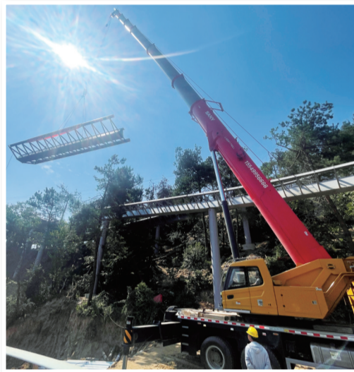
▼靠近山脚的健康步道吊装最后一根钢箱梁。
