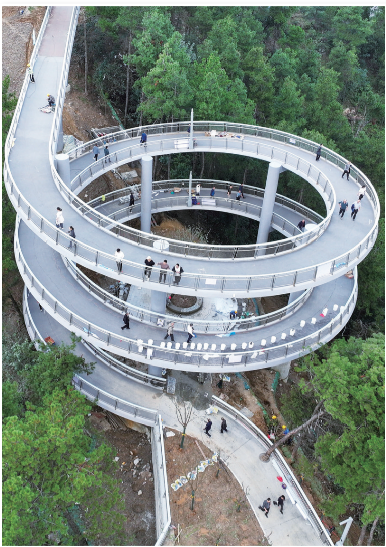
▲架空步道采用柱基支撑,最大限度保证自然山体原貌。
