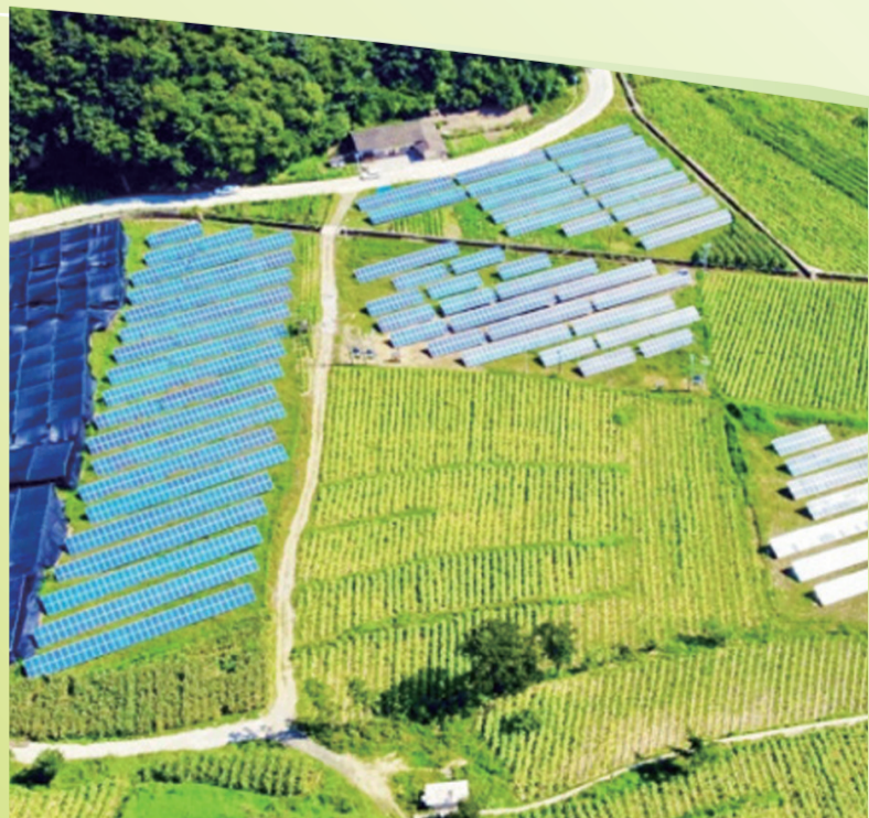
支持房县光伏电站一期回购项目
